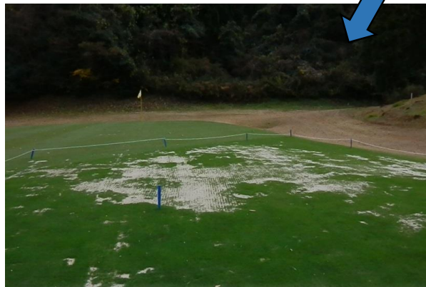
施工箇所及び裸地全体を目土砂で保護し、ロープを張って養生します
